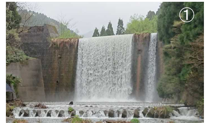
▲既存の砂防堰堤(S36年竣工) この機能復旧で本川貯砂ダムを設置 分水施設への安全対策のため 流木止めを新規設置
