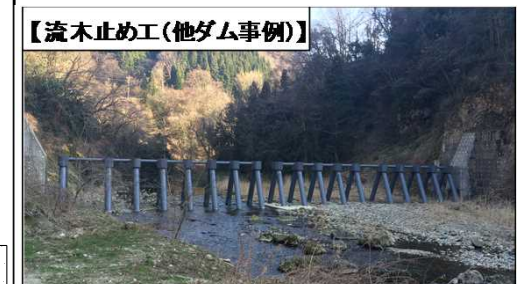
▲既存の砂防堰堤(S36年竣工) この機能復旧で本川貯砂ダムを設置 分水施設への安全対策のため 流木止めを新規設置
