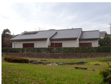
地区内に設置された壁画の仮設修理施設
