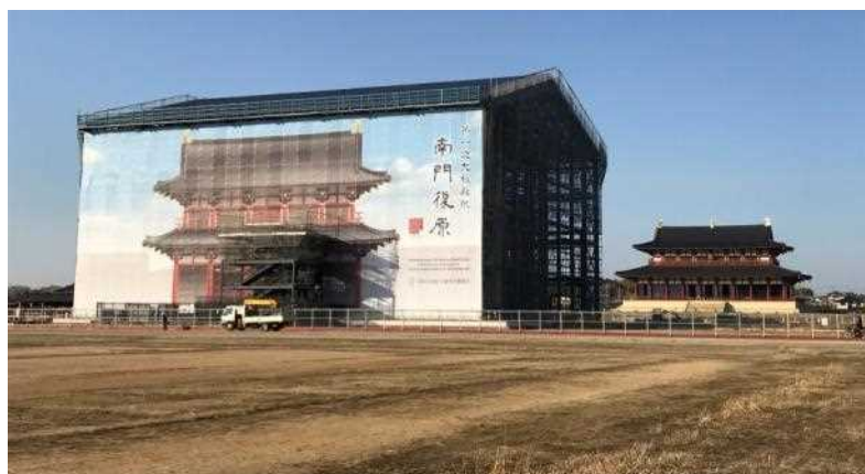
【南門復原整備工事の素屋根（手前）】
