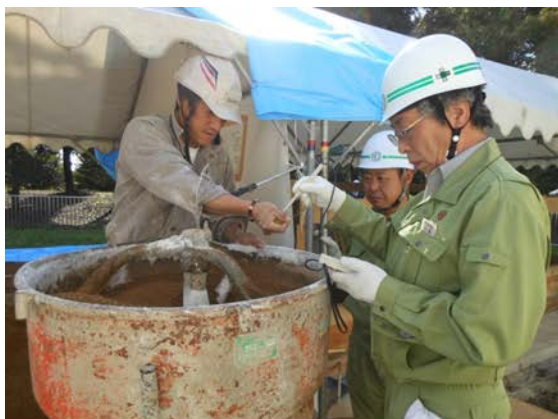
版築土調合状況および含水率測定
