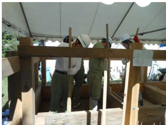
版築搗き固め作業状況
