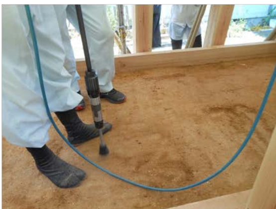
機械を用いた施工試験
