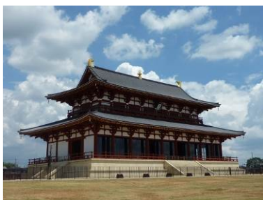
調査研究にもとづいて復原された第一次大極殿
