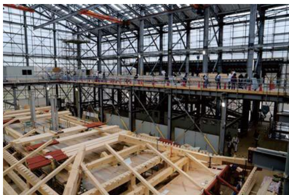
南門工事現場の特別公開イベントの様子
