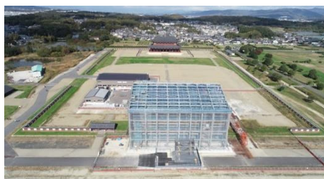
南門の素屋根工事の様子
