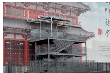
素屋根に貼られたイメージ図のシートと見学用デッキ
