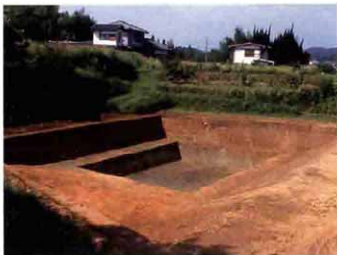
A-3区 全景 (北東から)
