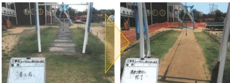
夢っこランド (ロープウェイ下マット反り返り) ゴムマット撤去→真砂土舗装
