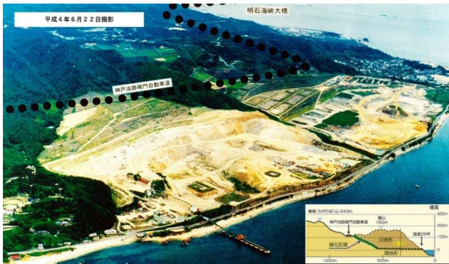
関西国際空港等の埋立に使用された土取場跡地
