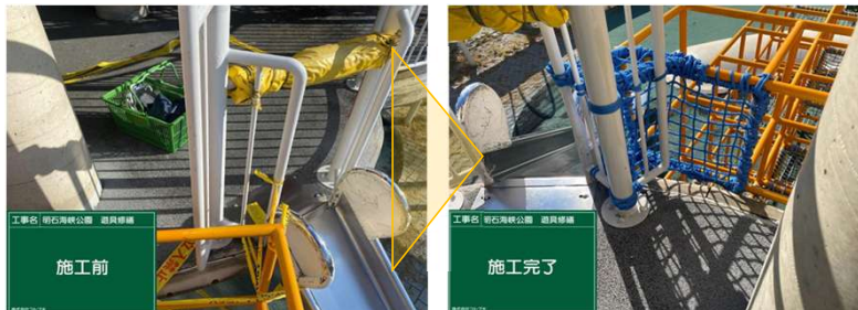
子供の森 (ジャングルジム安全措施) 頭部胴体首挟み込み防止ネット設置
